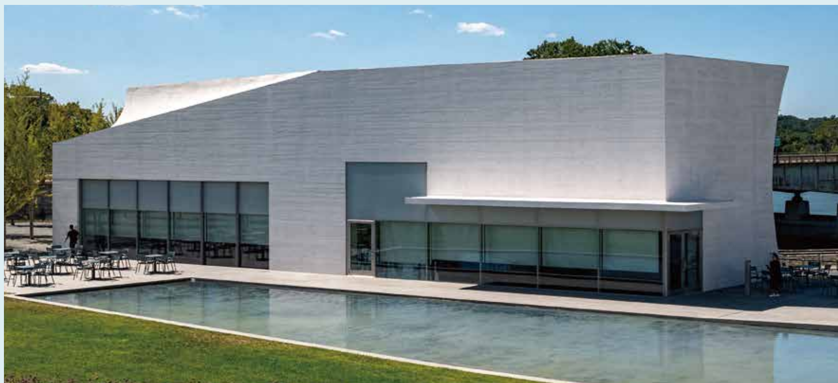
Pavillon de la rivière | Photo gracieuseté de PERI Formwork Systems
