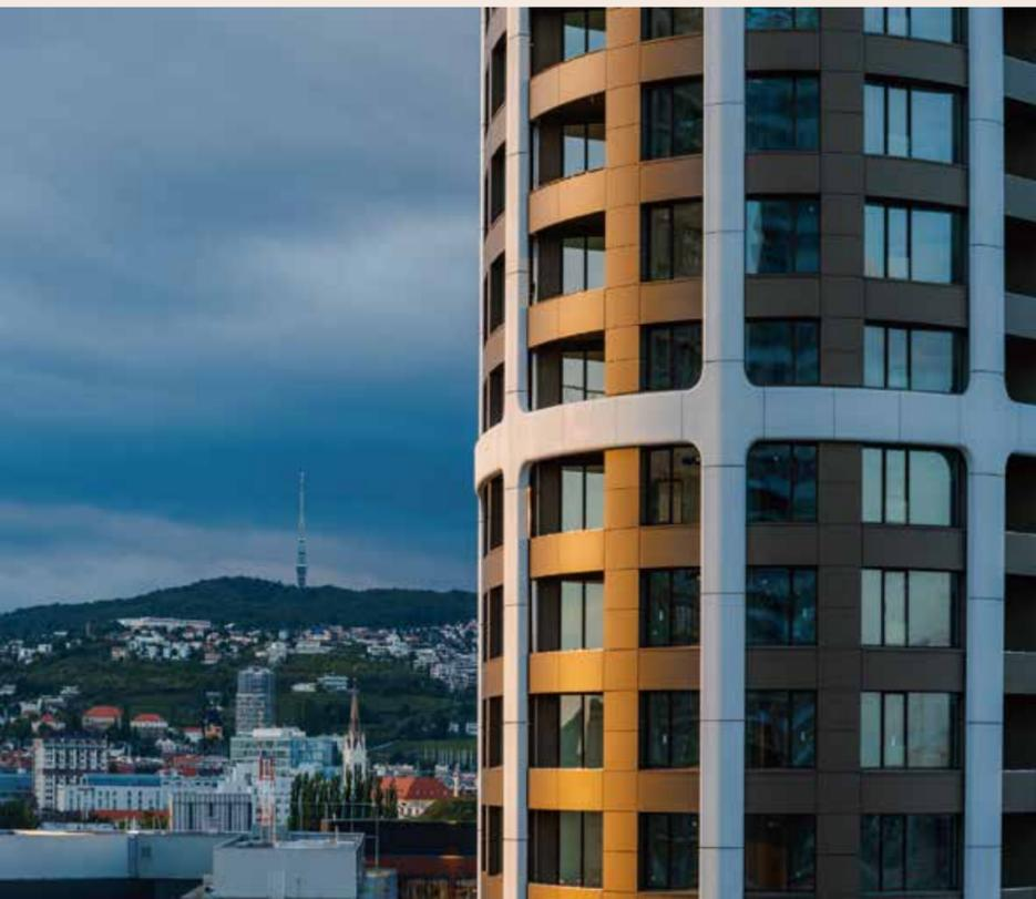
BB Fiberbeton A/S公司最近为斯洛伐克的三座高层建筑生产了GRC幕墙构件, 这些GRC作为天空公园的三座塔楼外立面解决方案之一。
