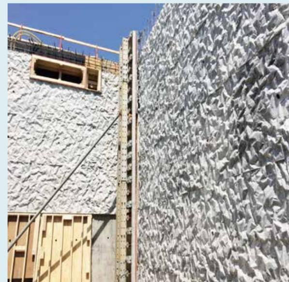
为确保THE REACH艺术中心演出时卓越的音质和控制效果,建筑物内部设计考虑的很周全,使得多个演出可以同时举办,而不会互相干扰。约11570平方英尺的垂直墙面空间采用定制的“皱褶混凝土”纹理,可以打破声波并避免平行墙之间的混响。这一独特的形式来自建筑师的物理弯曲金属板,以创造一个不规则的褶皱纹理,然后进行硅胶翻模,以现场浇筑方式建造出具有功能性的混凝土内墙。因此,这些墙既作为装饰墙,也是建筑的主要承重结构。设计师的技巧在于如何将不同的形式、饰面和纹理与物理布局结合起来,将许多功能空间分隔开来,同时提供一种和谐的、有感召力的游客体验空间。
