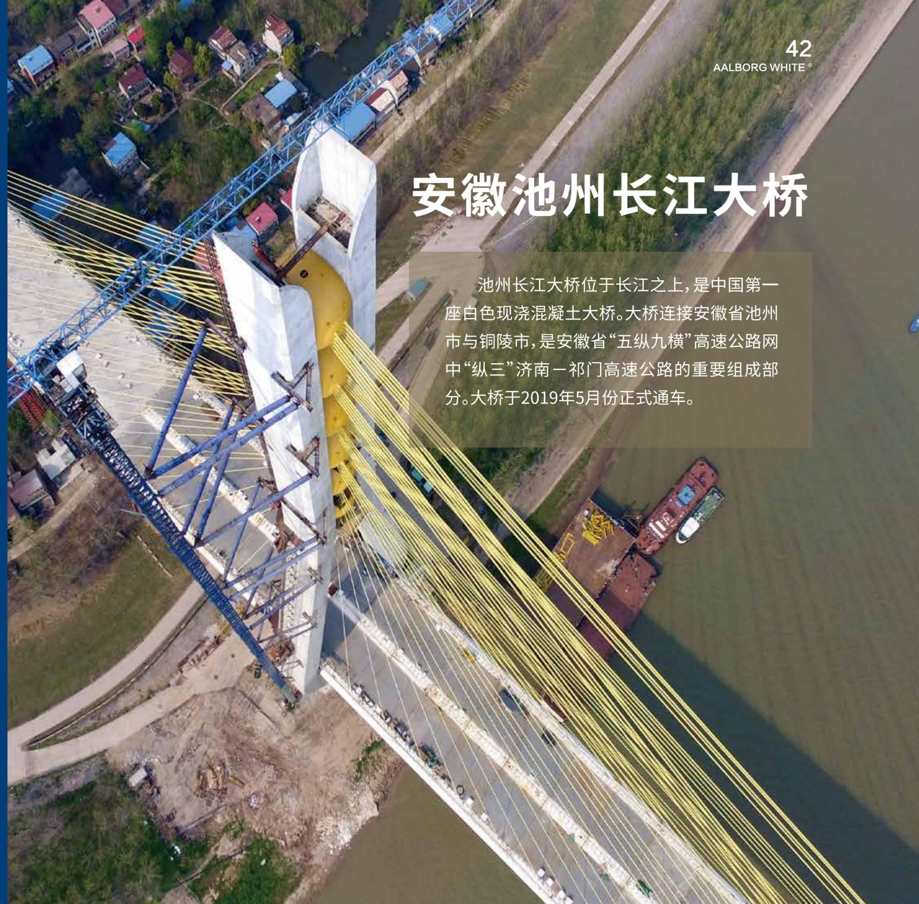
大桥主桥长5.8公里,连接南北两端高速公路全长41公里。斜拉桥两座塔分别高为237米和246米,由高耐久性纤维增强白色混凝土制成,共使用了5,000吨阿尔博®52.5级高强度白水泥。
