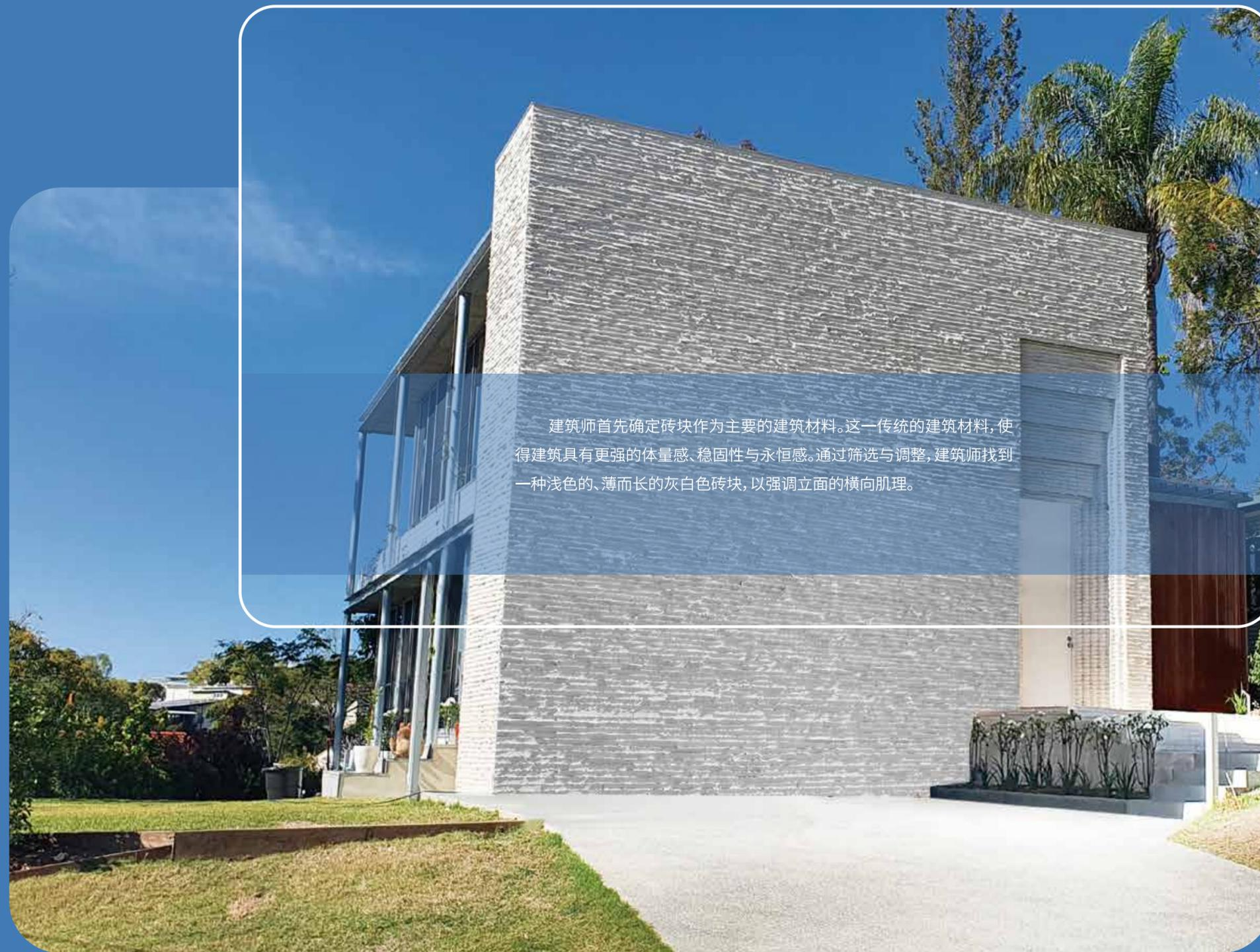
建筑师首先确定砖块作为主要的建筑材料。这一传统的建筑材料，使得建筑具有更强的体量感、稳固性与永恒感。通过筛选与调整，建筑师找到一种浅色的、薄而长的灰白色砖块，以强调立面的横向肌理。
