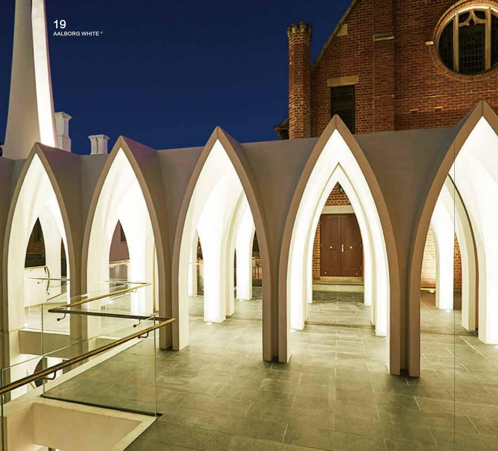
由于项目建于现有建筑之间,这对装配预制混凝土构件构成了重大挑战,因为构件需要用卡车起吊60米高度,然后才能达到最终位置。尽管施工难度很大,但这不影响建筑物的整体美观度。由阿尔博®白水泥制成的优雅白色预制混凝土立面、由U形柱支撑的白色混凝土尖顶拱门形成的柱廊,以及卡多安唱诗班学校的每一个独特设计都受到大教堂柳叶窗的启发。
