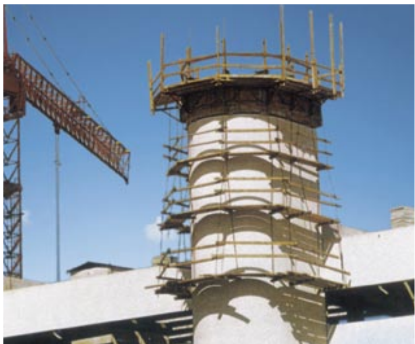
Gleitschalung, Krankenhaus Herlev (Kopenhagen).
