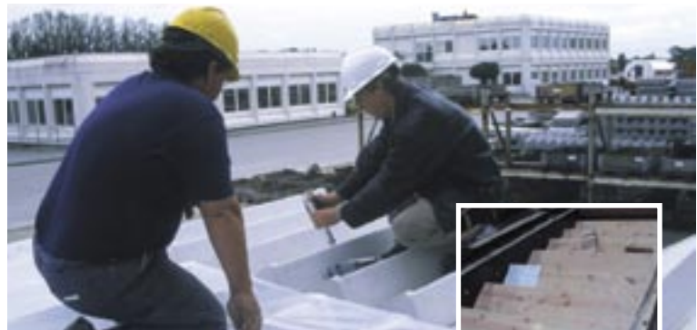
Durch Holzschalung entstandene Oberfläche
