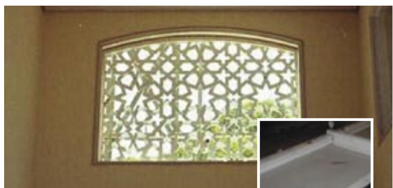
Durch Kunststoffschalung entstandene Oberfläche
