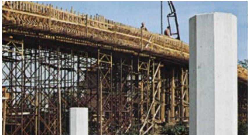
Schalung für Fußgänger- und Fahrradbrücke aus weißem Beton
