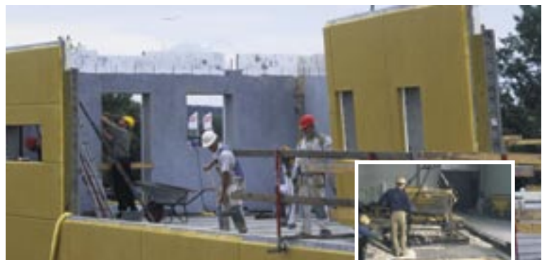
Durch Stahlschalung entstandene Oberfläche
